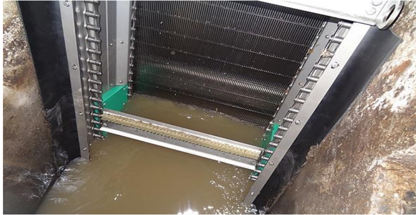
Figure02 : Installation des dégrillés automatiques fins
