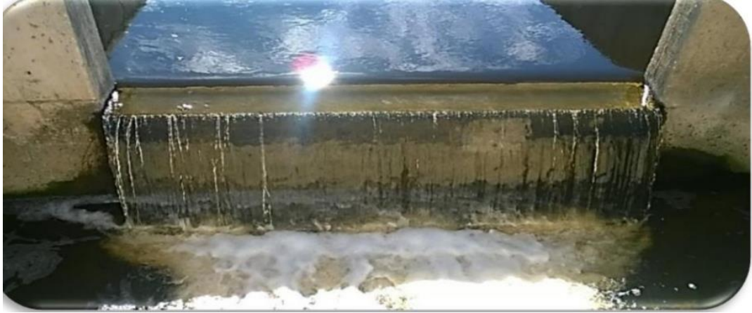
Figure 23 : Le bassin de chloration (la sortie des eaux épurée) (Hafsaoui,2020)
