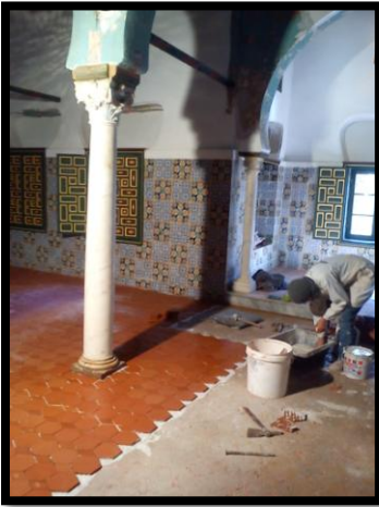
صورة رقم (38): عمليات الترميم الجارية بقصر الباي 3 .
