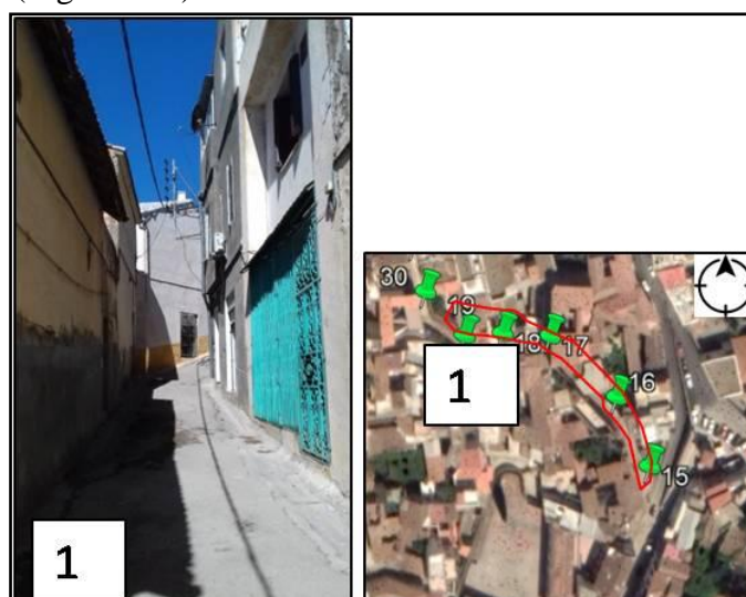
Figure 128: Présentation de la ruelle Saidani . Source : Google Earth modifiée par K. Ikni 2019.
