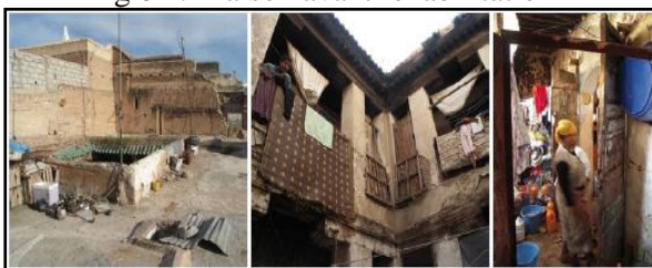
Fig 01 : Maison avant réhabilitation
