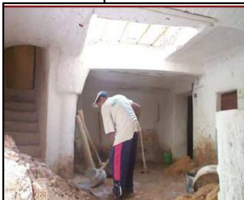
Fig 25 : maison pendant réhabilitation
