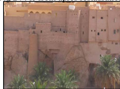
Fig 24 : le front après restauration
