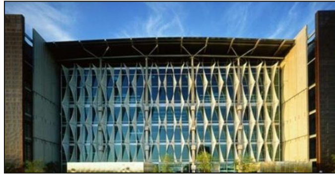
Figure III.18: Pare-soleils extérieur pour paroi vitrée orientée nord, (Bibliothèque centrale de Phoenix, Arizona)
