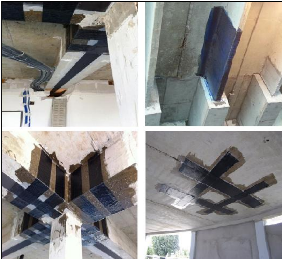
Figure I-7 : Plusieurs usage de la technique de renforcement EBR (Teng et al., 2002).
