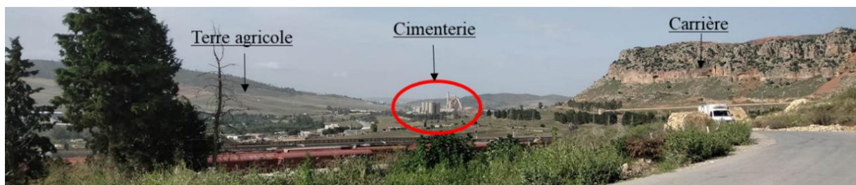
Photo 13 : Vue de la cimenterie à partir de Djebel Salah
