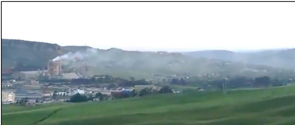
Photo 15 : Emissions de poussières en 2016 - Une défaillance des filtres durant le processus de fabrication du ciment-
