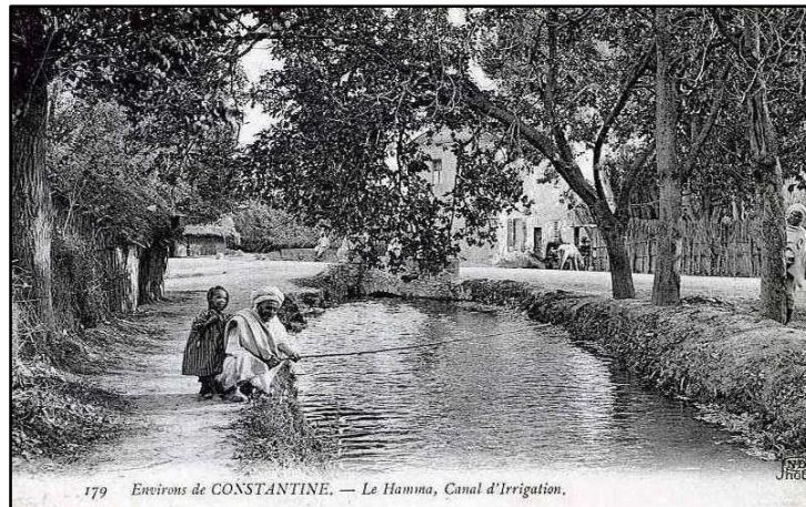
Photo 4 : Canal d'irrigation dans la commune de Hamma Bouziane pendant la période coloniale
