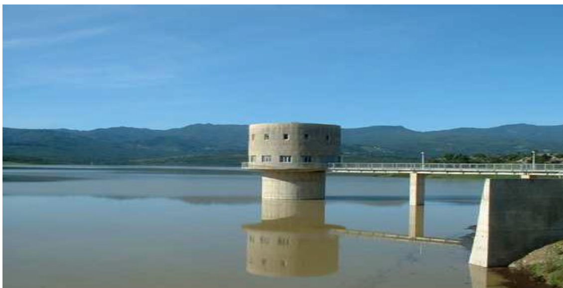
Figure 4. Photographie du barrage Beni Zid.
