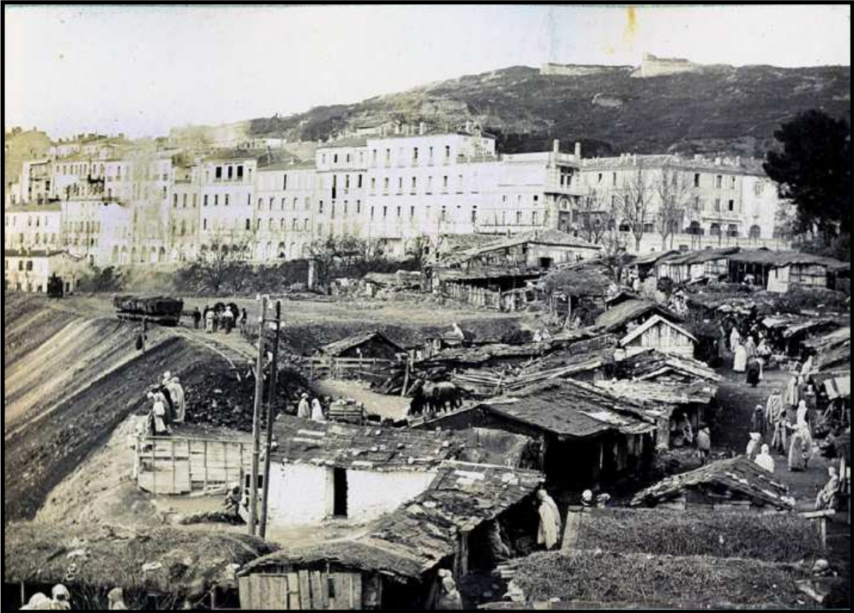
Encadré n°13 : Vue prise de la porte Djebia montre l'installation des familles algériennes dans des constructions précaires
