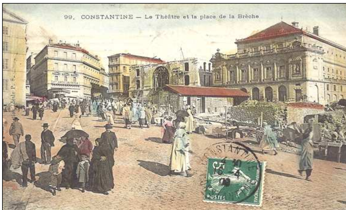
Encadré n°38 : Les travaux de constructions du crédit foncier du coté nord et de la poste au sud du théâtre.
