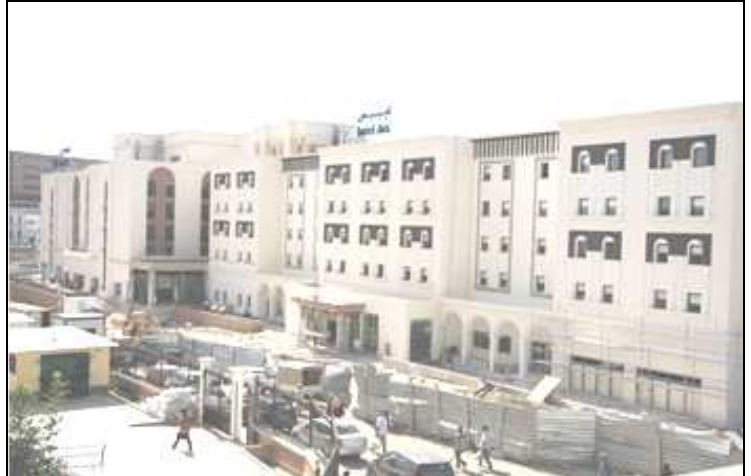
La réalisation en phase finale en 2011
