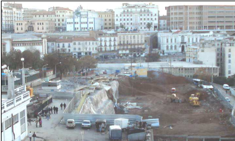
Les terrassements en 2006
