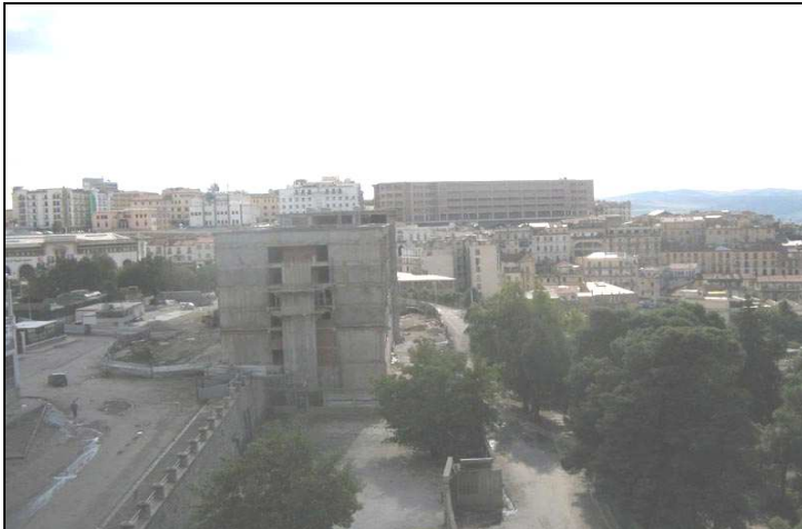
Durant les travaux de construction en 2009
