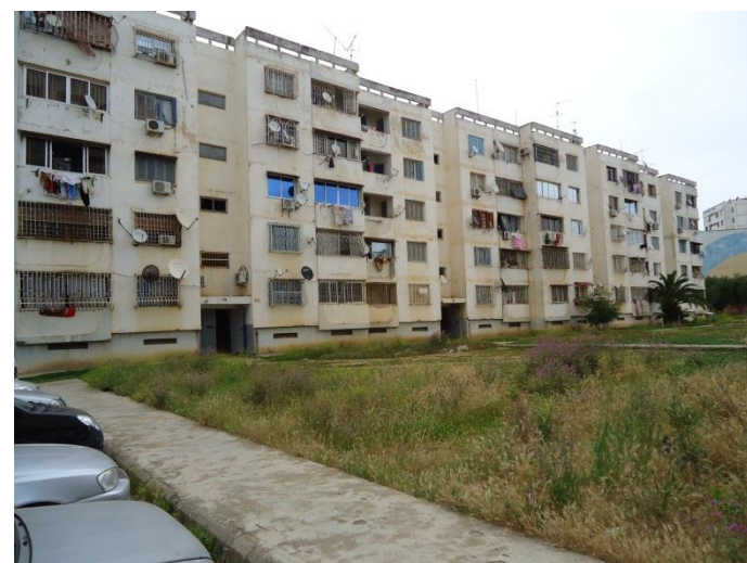
Figure 41 : La cité Soummam (1025 logt.) -Bâb Ezzouar- (Auteur, 2013)
