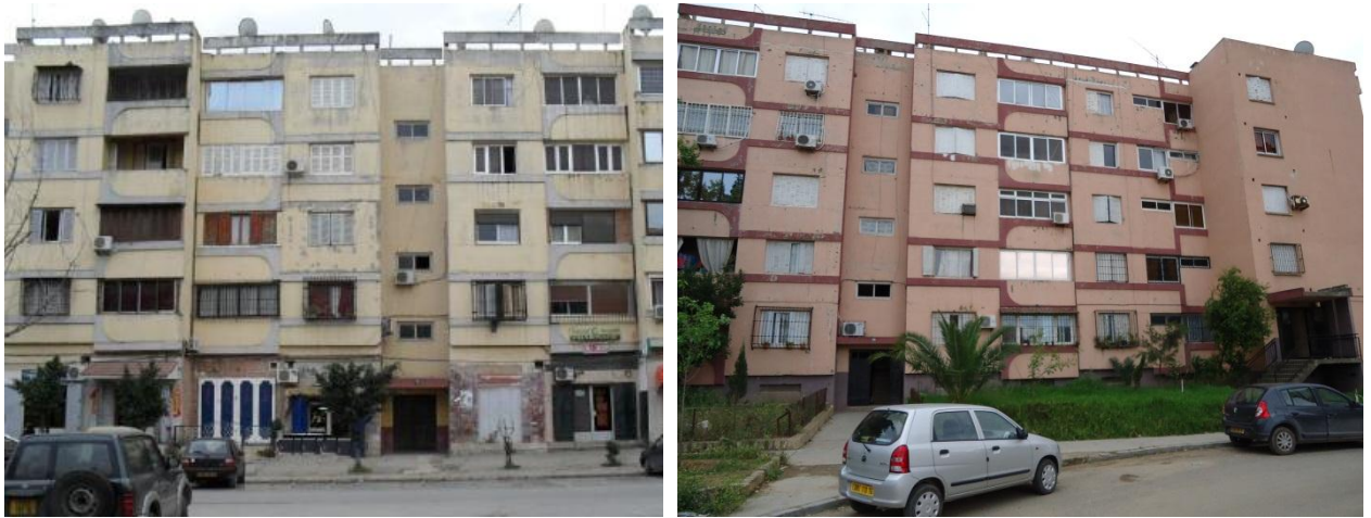
Figure 66 : Cité Tahar RABIA, Bâb Ezzouar (Source : Auteur 2013)
