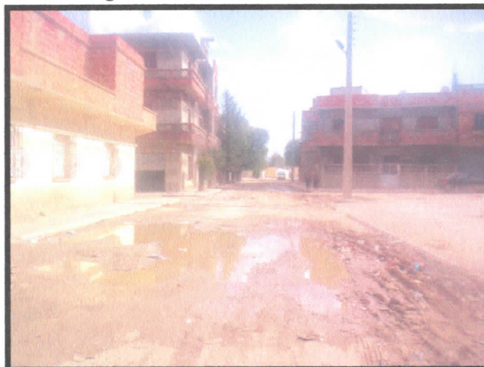
Photo N° 03 :dégradation de la voirie cité technicum
