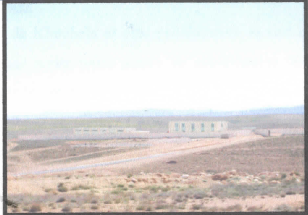
Photo N° 02 :CET Baghai Vue Générale
