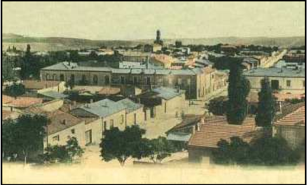
Photo n°31 : l'image du village de kenchela à l'époque coloniale (le village prit corps, des constructions basses et harmonieuses Source : SCU kenchela, phase 2
