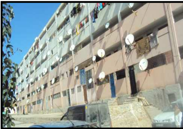
Photo n° 32 : L'habitat collectif au niveau du le tissu central Source : L'auteur (Août 2010)
