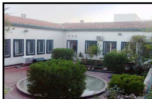
Photo n° 22: Habitat individuel (colonial) avec cour à l'intérieure Source : auteur
