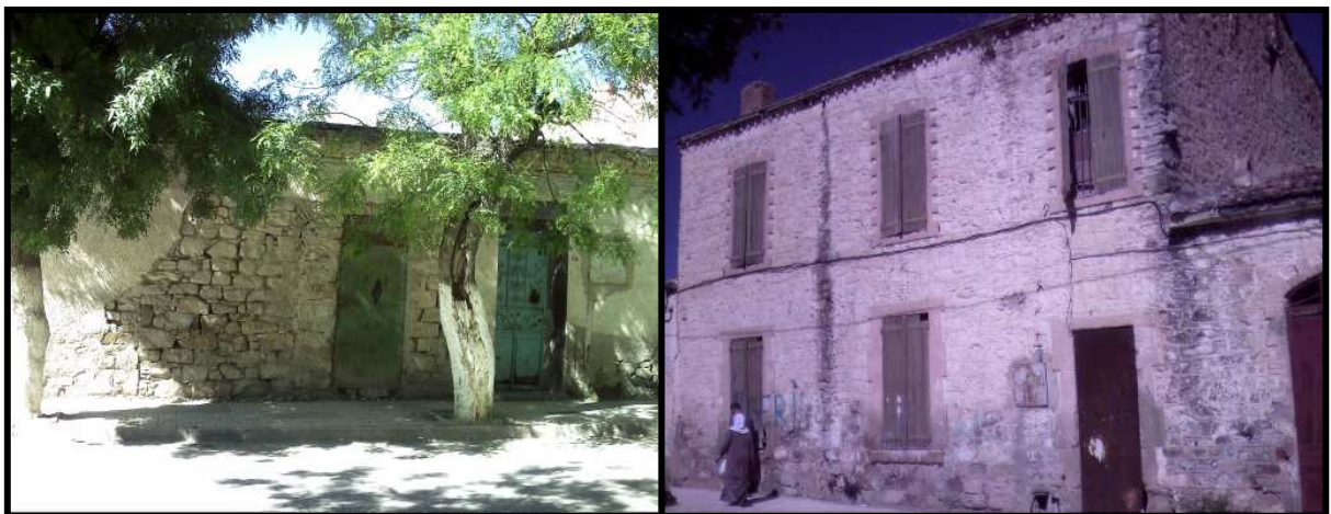
Photos n°61, 62: centre ville de khenchela, la dégradation au niveau des habitations de copropriété en indivision
