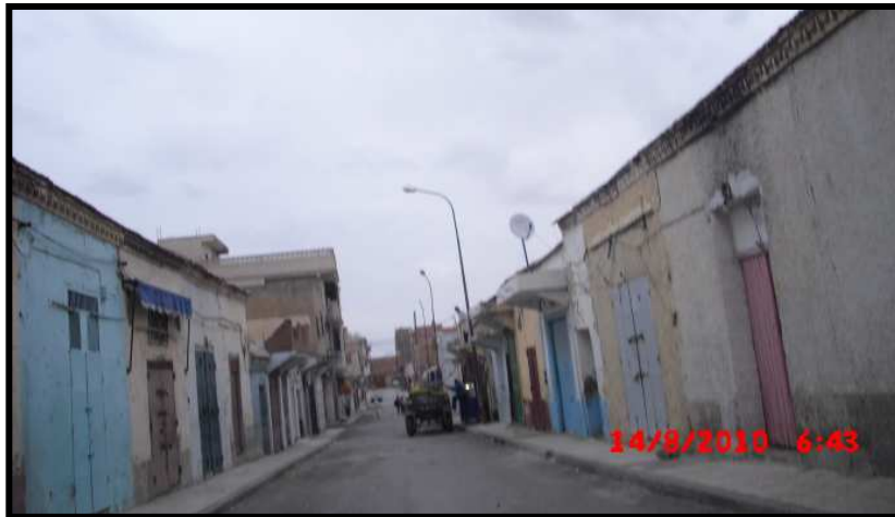
Photo n°67 : centre ville de khenchela, la dégradation des habitations et des locaux commerciaux occupés par les locataires
