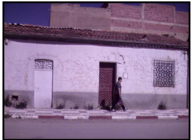
Construction en moyen état
