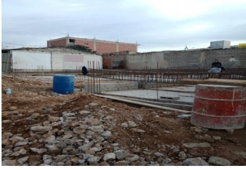
صورة 06: إعادة بناء شاليهات RHP
