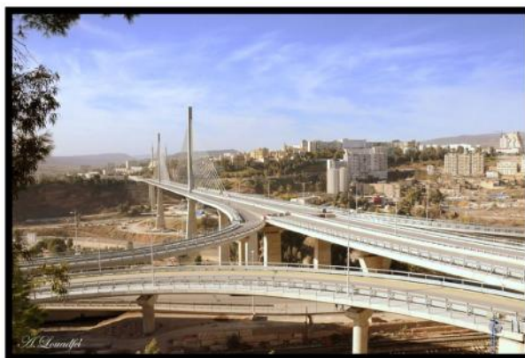
Fig.N°64 : vue général sur le Pont Salah Bey
