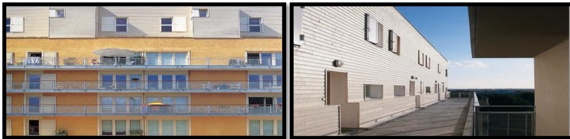
Photo 01: Façades de la résidence Salvatierra, ZAC de Beauregard, Rennes
