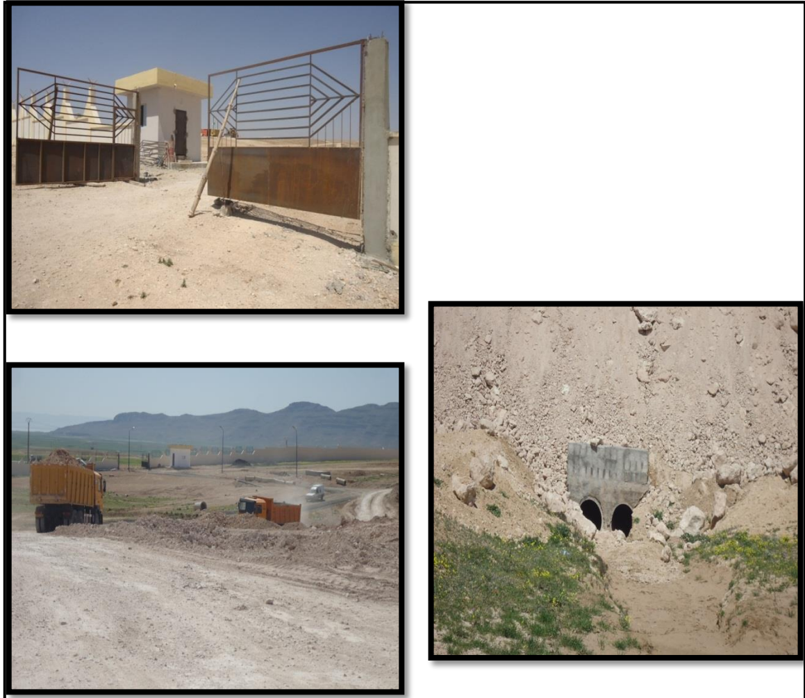
Figure n 41 : Avancement des travaux.
