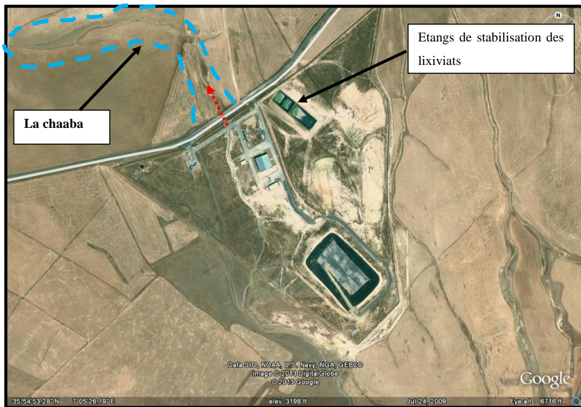
Figure n 37 : Evacuation des lixiviats vers la chaaba sans aucun traitement.
