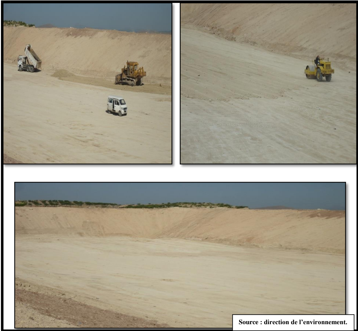
Figure 27: L'emplacement d'une couche d'argile compactée au niveau du casier destiné pour l'enfouissement des déchets
