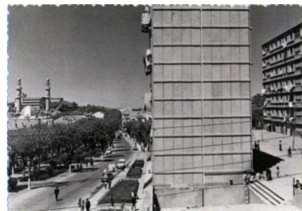
Fig.70: vue sur la cite Bouziane construite au bord de la route nationale 18
