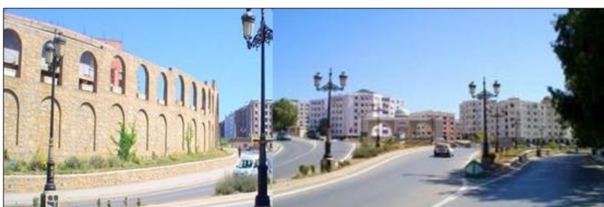
Fig.84 : Vue sur le pôle urbain et le nouveau élément qui représente la réplique de la porte des arcades
