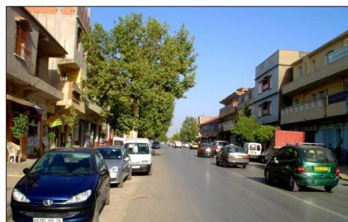
Fig.86: Vue sur les deux rives du boulevard, des constructions à usage d'habitat caractérisées par un front continu
