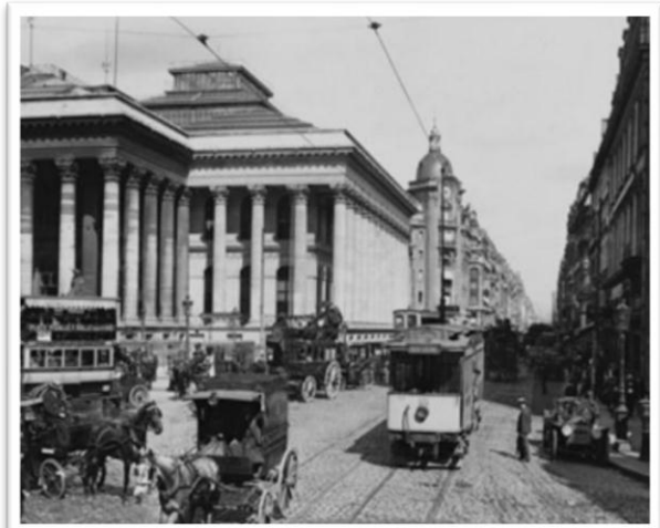
Fig.08: photo d'une rue parisienne à l'aube du 20 ème siècle Source: (anonyme)
