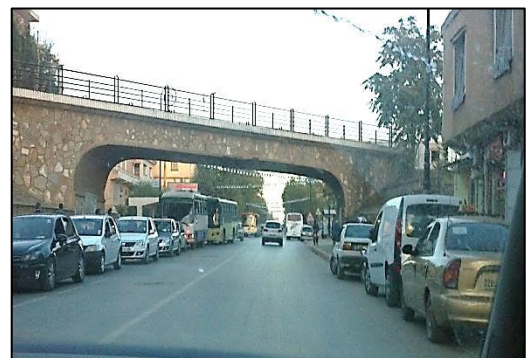
Fig.95: le passage sous le pont ferroviaire Source: photo prise par l'auteur 03/10/2014
