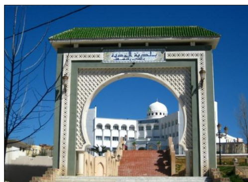
Fig.79: Vue du siège de l'APC après le traitement de sa façade et le rajout d'une coupole sur sa toiture, ainsi que la porte urbaine monumentale qui le démarque. Source: photo prise par l'auteur, 15/12/2013
