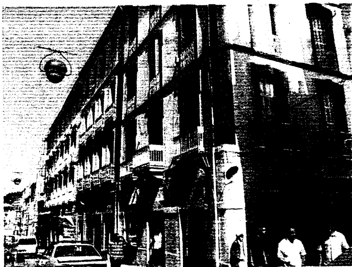
Photo n°20 : Réhabilitation de la rue Larbi Ben M'hidi
