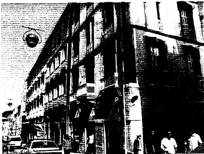
Photo n°20 : Réhabilitation de la rue Larbi Ben M'hidi
