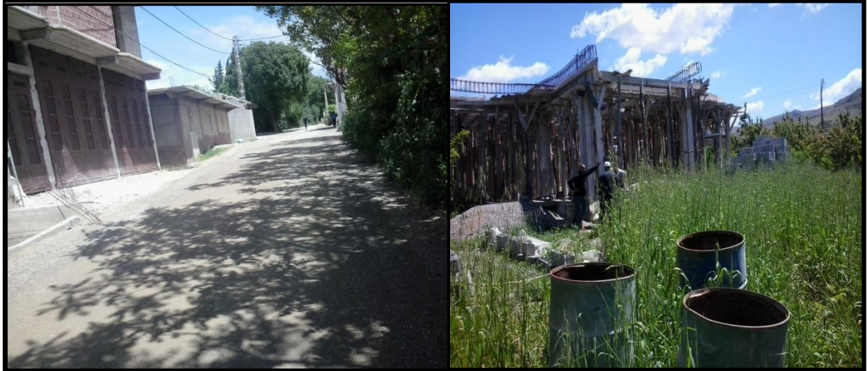
Figure 43: Logements ruraux hors normes de surface au cœur des exploitations agricoles. Source: Cliché de l'auteur, 2014.
