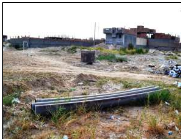
Photo 5.19 : implantation du réseau d'assainissement (quartier Guarra)
