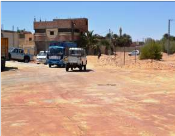
Photo 5.12 Fissures périodiques (4 – 6 mois), effondrement sec (Sidi Mastour)
