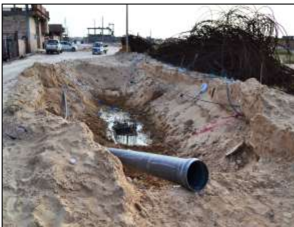
Photo 5.18 : Raccordement au réseau d'assainissement (quartier Guarra)
