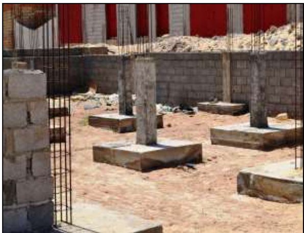
Photo 5.29 corrosion des fondations (quartier Sidi Mastour)
