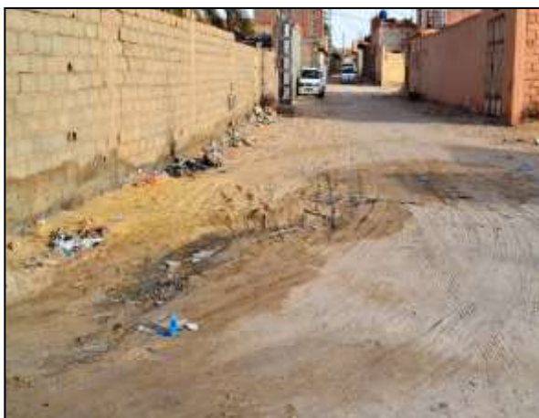
Photo 5.8 : Effondrement humide, traces humides (quartier Guarra)
