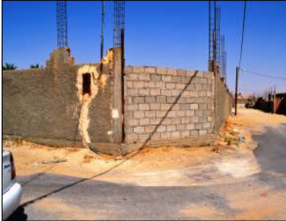
Photo 5.46 : Murs saint sans fissures (Robbah cité Zaouia Est)
