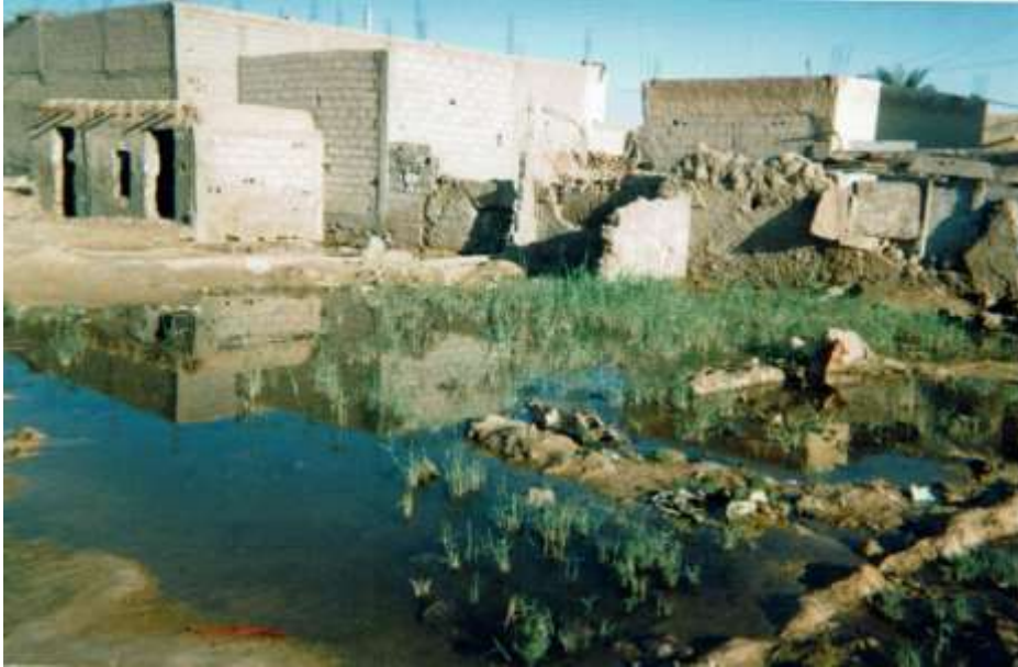
Photo 4.3. Cité Nezla Effondrement des bâtis Mars.2006. Source : prise par L'hauteur.
