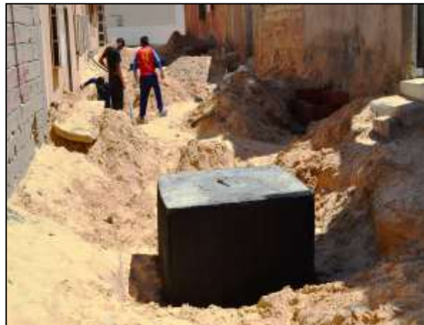
Photo 5.17 : Raccordement au réseau d'assainissement, Axe tertiaire (S Mastour)
