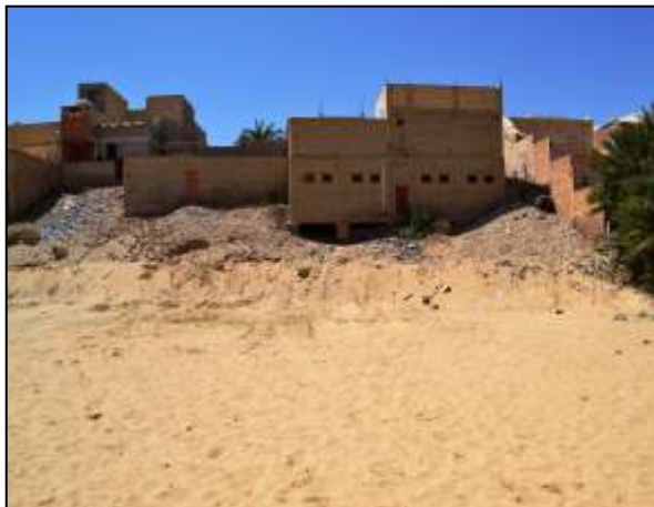
Photo5.30 : Pas d'inondation, pas de roseaux Ghout Quartier Sidi Mastour.
