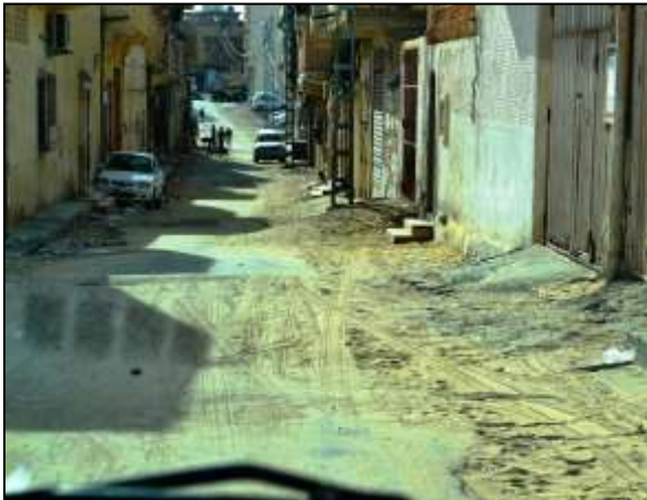
Photo 5.6 : Effondrement sec, déformation d'un axe tertiaire (quartier
