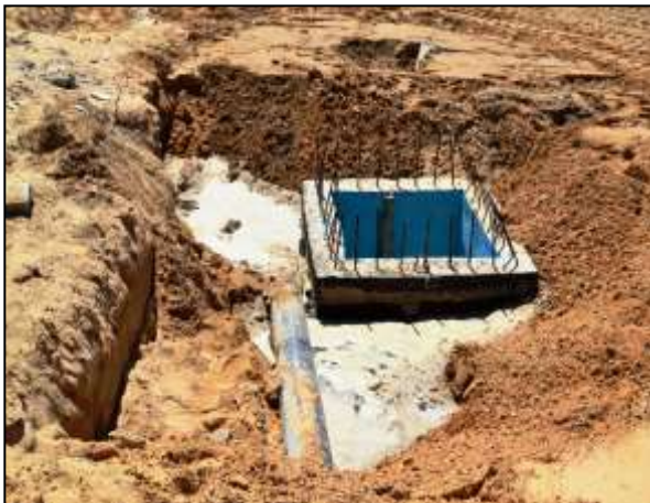
Photo 5.16 : Raccordement au réseau d'assainissement (quartier Sidi Mastour)
