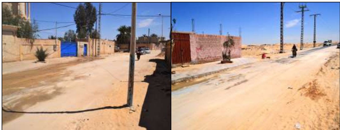
Photo 5.11 : Effondrement humide (quartier Sidi Mastour)
