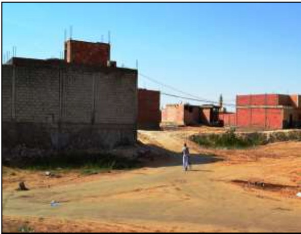
Photo5.26 : traces humides, et corrosion (extension urbaine quartier Sahen01)
