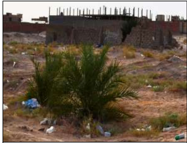
Photo 5.23 : corrosion des murs et pilier (bâti du type traditionnel quartier Guarra)
