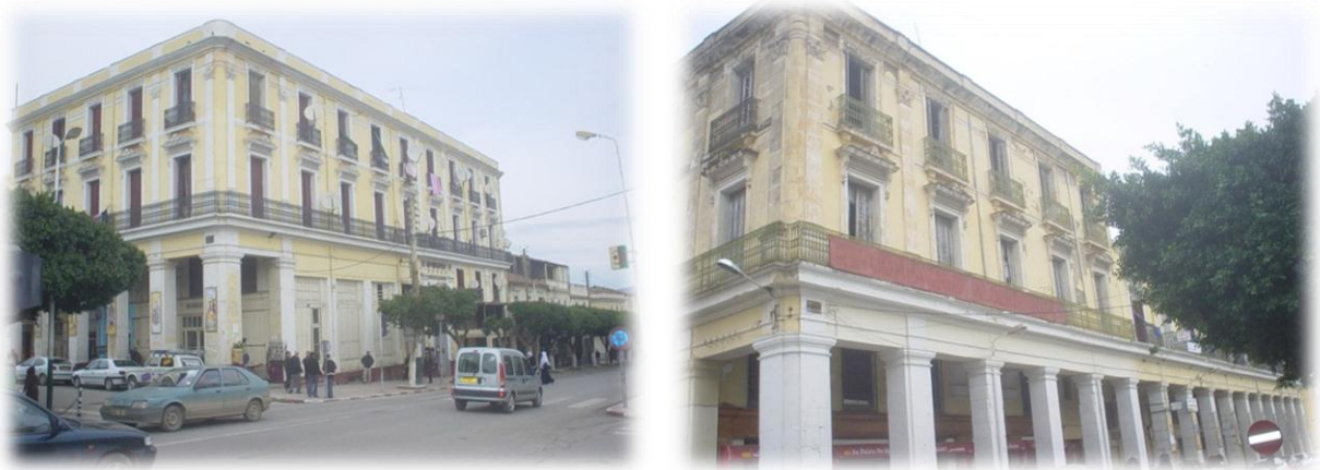
Figure 9 : Etat dégradé des anciennes constructions (PDAU)
