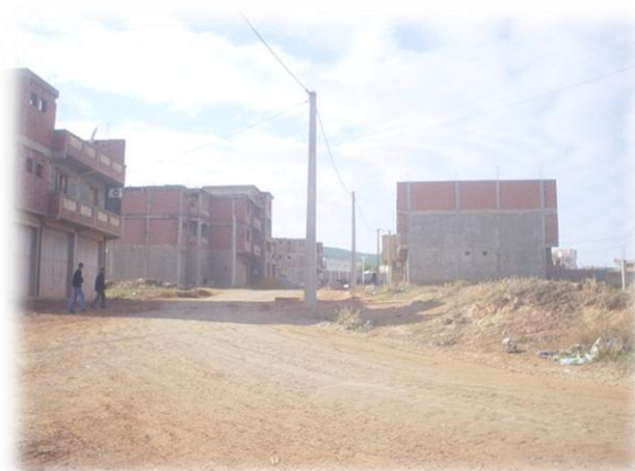
Figure 12 : Lotissements constructions généralement inachevées (PDAU)
