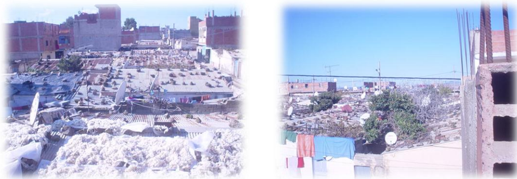
Figure 7 : Cité de recasement El Hafsi toit en éternit (PDAU)
