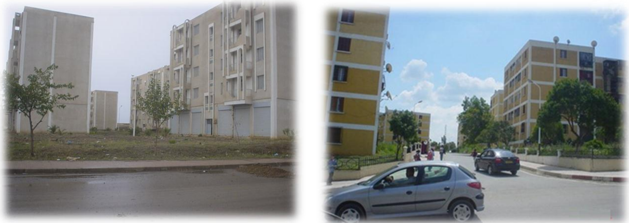
Figure 13 : Habitat collectif nouvellement réalisé à gauche Cité frères REHABI, à droite cité Guehdour (PDAU)
