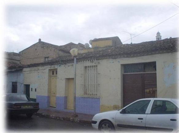
Figure 10: L'état des constructions est relatif à leur âge et au manque d'opérations de réhabilitation et d'entretien (PDAU)
