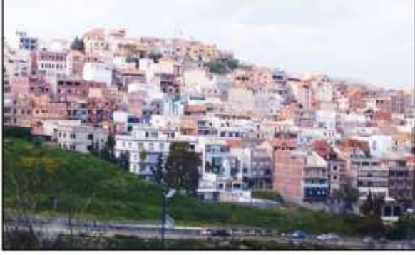
صورة رقم 11 : صورة للسكن الفردي بناء ذاتي حي الكاليتوس
