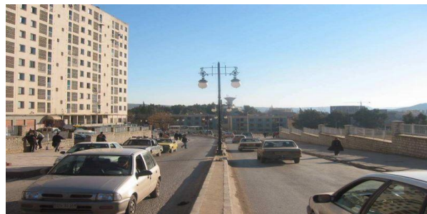
Photo 14 : Boulevard Boumedous avant l'insertion du tramway Source : (Kaghouche, 2010)
