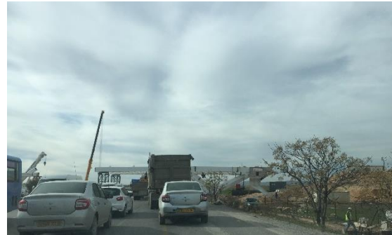
Photo 11 : Congestion automobile causé par le chantier du tramway au niveau de l'Autoroute Est-Ouest Source : Auteur, 2018
