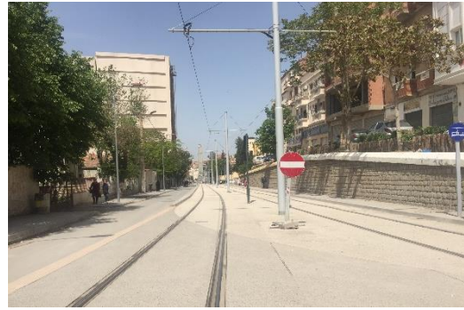
Photo 21: Insertion latérale avec une seule voie de circulation (centre-ville) / tramway de Sétif Source Auteur, 2018
