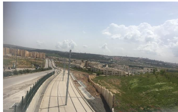
Photo 33: Tramway de Sétif en périphérie : insertion latérale avec doubles chaussées carrossables Source : Auteur, 2018
