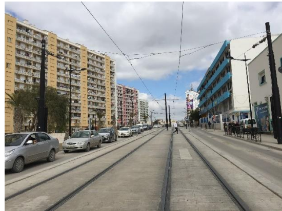
Photo 8 : Tramway à Constantine : insertion centrale au boulevard Cilic Source : Auteur, 2017
