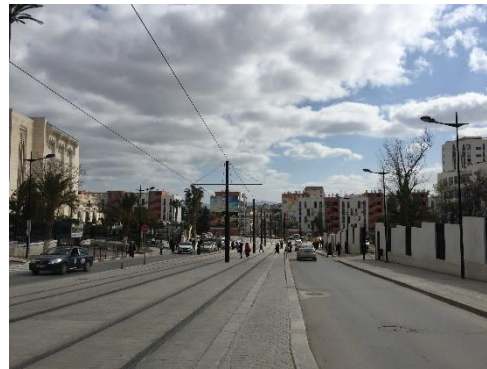
Photo 2 : Tramway à Constantine : insertion centrale, centre-ville, Station Emir Abdelkader Source : Auteur, 2017
