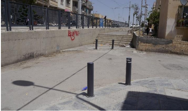
Photo 24: Ecart de conception : rompe non conforme/ tramway Sétif Source Auteur, 2019
