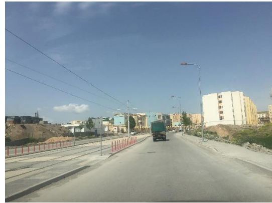
Photo 35: Tramway de Sétif en Périphérie : le corridor bétonné
