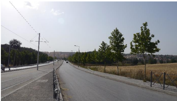
Photo 22: Insertion centrale avec deux voies de circulation (en périphérie) / tramway de Sétif Source Auteur, 2019
