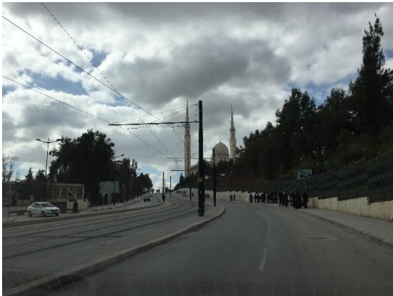
Photo 7 : Tramway à Constantine : insertion centrale à la Rue Che Guevara Source : Auteur, 2017
