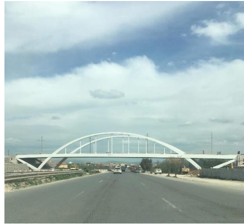
Photo 6 : Tramway à Constantine : Viaduc Autoroute Est-Ouest Source : Auteur, 2019
