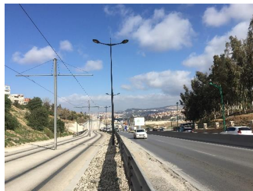
Photo 4 : Tramway à Constantine : insertion latérale, RN 79, Station Zouaghi Source : Auteur, 2017
