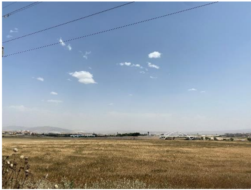
Photo 10 : Tramway à Constantine : insertion de la ligne dans la zone périurbaine Source : Auteur, 2021
