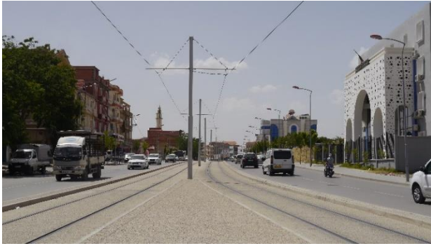
Photo 20: Insertion centrale avec deux Voies de circulation (centre-ville) / tramway de Sétif Source Auteur, 2019
