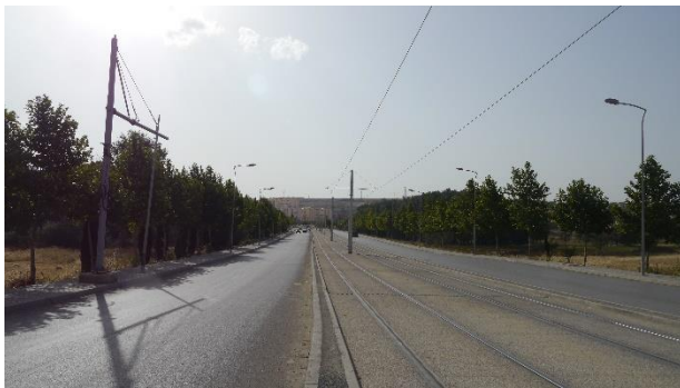
Photo 32: Tramway de Sétif en périphérie : insertion centrale avec doubles chaussées carrossables Source : Auteur, 2019
