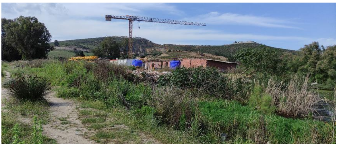
Figure 14 : Chantier de construction autour du marais de Boussedra (Hennouni, 2019)
