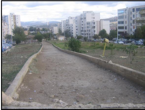
Photo N°78 : Monotonie et répétitivité des immeubles et leur dispersion sur de terrains vastes dans la ZHUN de Boussouf.
