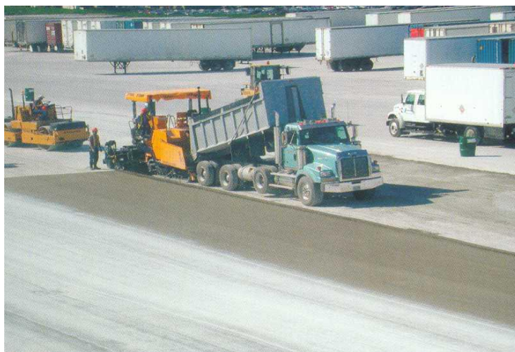
Figure 2.1 : Mise en œuvre du BCR [29,30].
