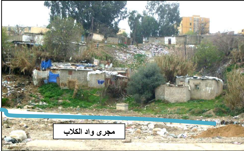
الصورة 19: الرمي بمياه الصرف الصحي لحي شعباني بالدقسي مباشرة في واد الكلاب
