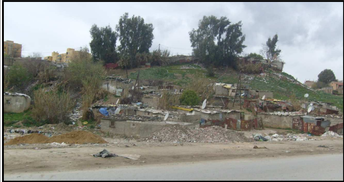
الصورة 17: بقاء المساكن القصديرية لحي شعباني بمحاذاة الواد
