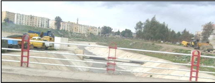
الصورة 25: تهيئة سفوح واد الكلاب بالدعائم الإسمنتية
