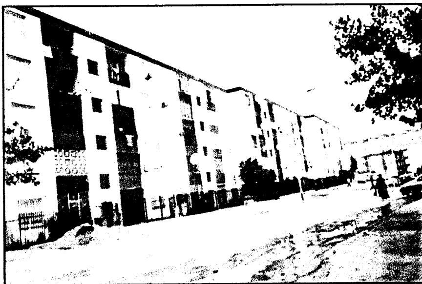
Photo n° 08 : la façade d'un immeuble après réhabilitation
