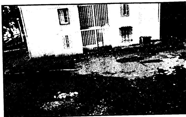
Photos 03 : espaces extérieurs insalubres
