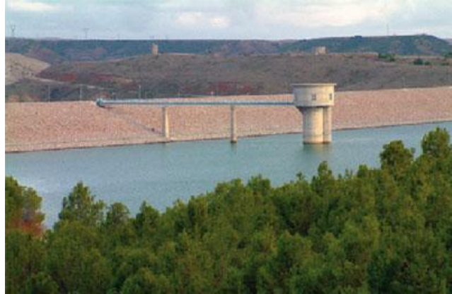
Figure 4: Vue représentant la digue et la tour du Barrage de Ain Zada (Sétif) ( site web 1 ).
