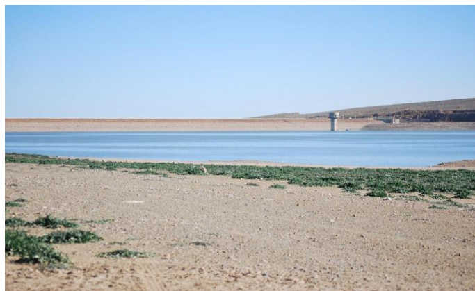
Figure 5 : Vue panoramique du barrage de Koudiet Medouar « Timgad, Batna ». ( Photo personnelle : 12/01/2014 ).
