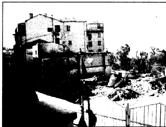
Photos N°4 : MAISON CADOT SISE A BELOUIZDAD APRES DEMOLITION
