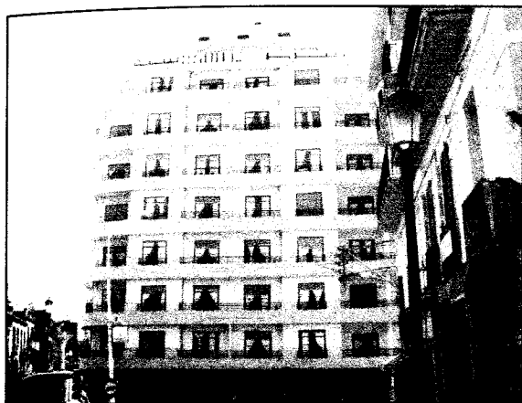
Photos N°3 : MAISON CADOT SISE A BELOUIZDAD APRES EVACUATION ET AVANT DEMOLITION
