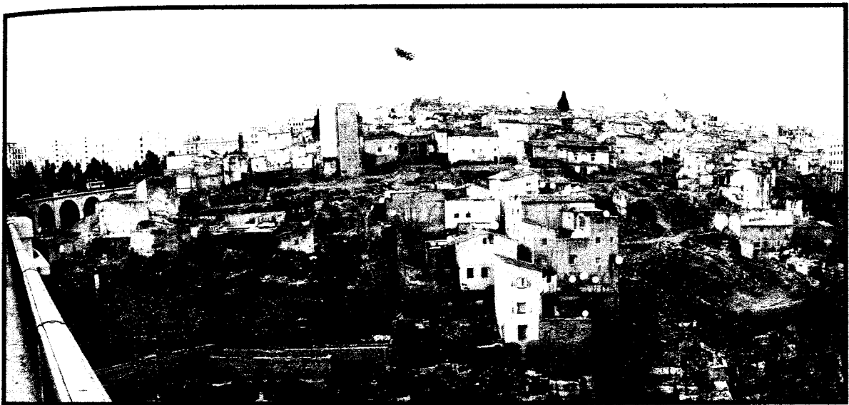
Photo N°8 : SOUIKA EN ETAT DE DELABREMENT AVANCE 2005
