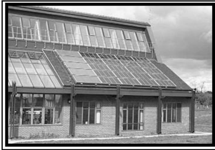
Figure 3.8 : Capteurs solaires combinés intégrés à la toiture du Brockshill Environment Center.
