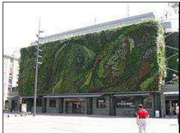
Photo n° 25 : Mur végétal installé sur la façade des Halles à Avignon (place Pie).
