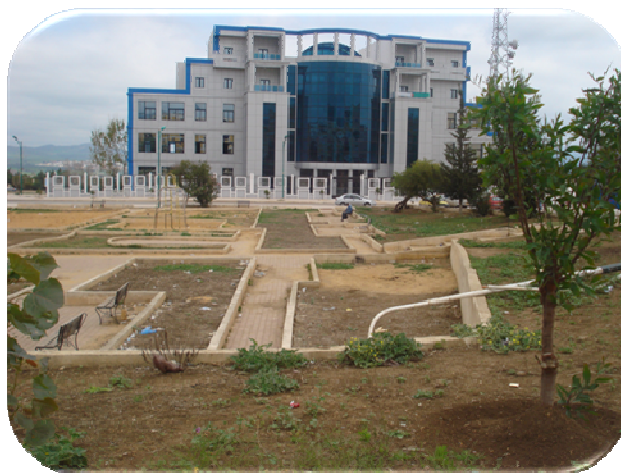
Photo n°136 : Aire de jeux avec mobilier urbain endommagé.
