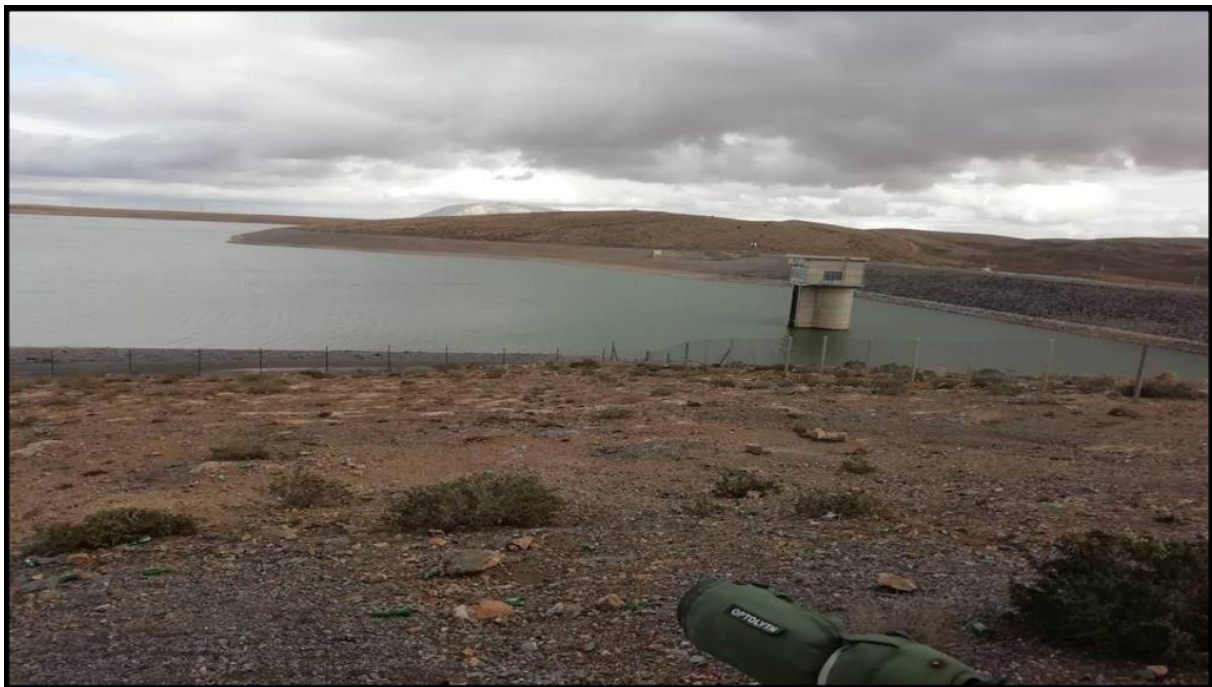
Figure. 47 : vue général du barrage d'Ourkis (SENOUSSI, 2019)
