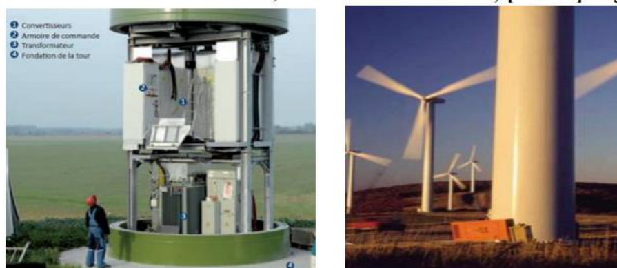
Fig.I.12: Composants électroniques de la tour éolienne.
