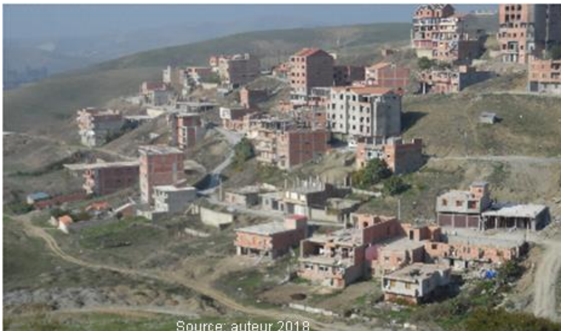
Figure 119 : habitat individuel en cooperative dans l'espace périphérique
