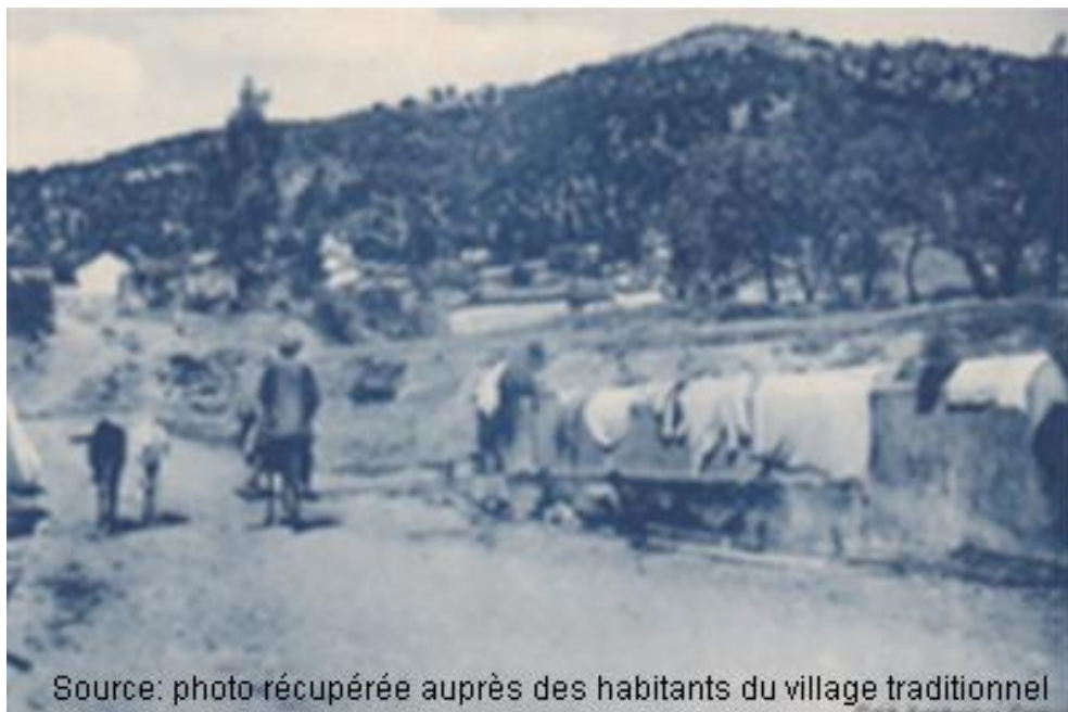
Figure 81 : photo de l'état initial de la fontaine Ain hallouf
