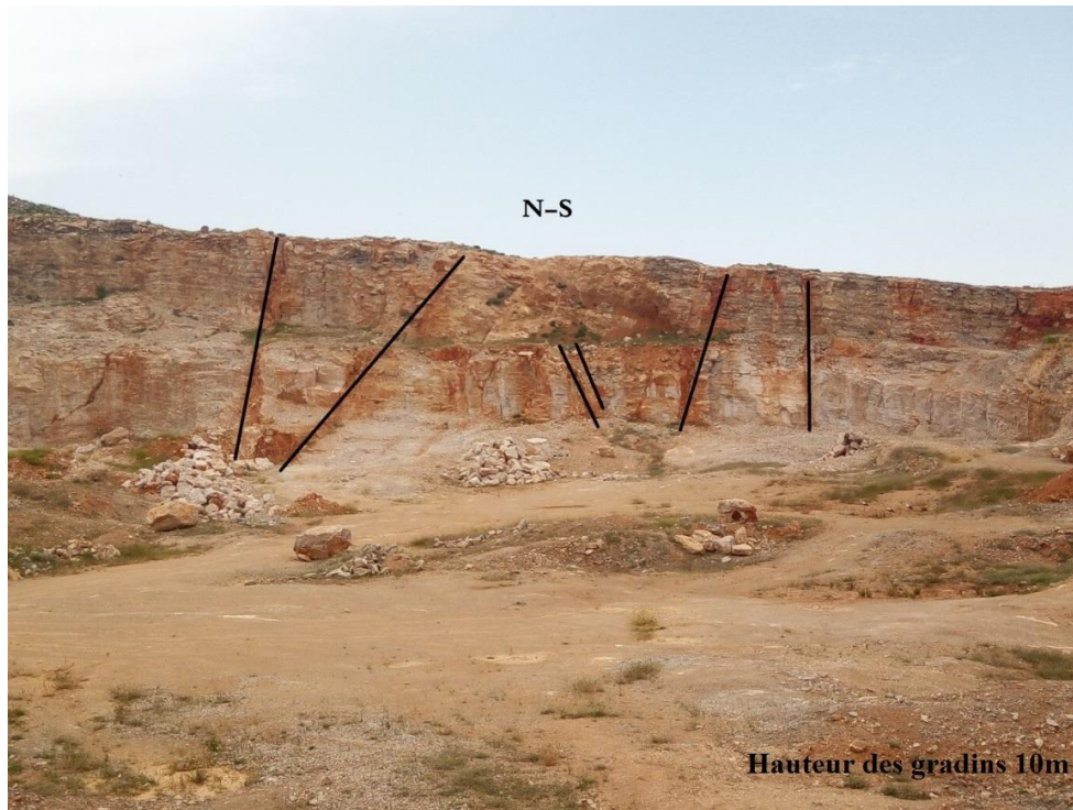
Photo.4 : Famille de failles de directions N-S au niveau de Djebel Felten
