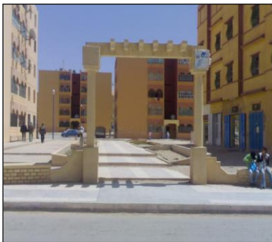
صورة رقم (66) أحد المداخل الرمزية في المنطقة (D1) يساهم في إعطاء هوية مميزة للمنطقة ويحد من دخول المتسكعين
