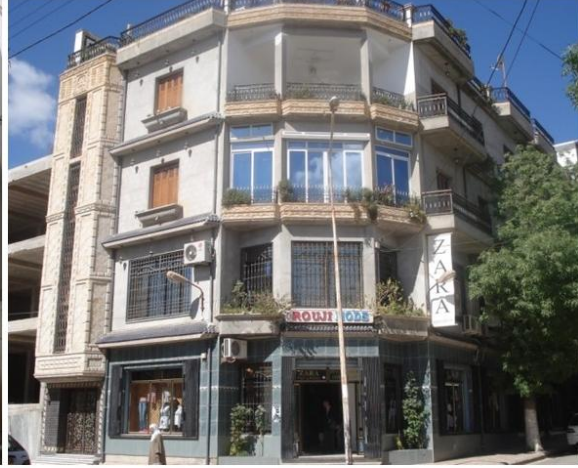
إعادة بناء بعد الهدم وتخصيص الطابق الأرضي للنشاط التجاري
