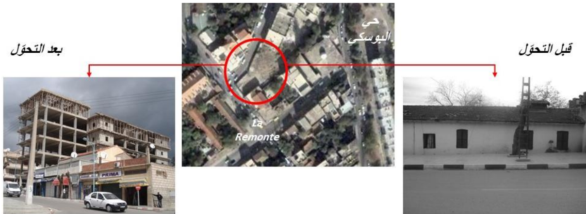
صورة (36): هدم وإعادة بناء مع تغيير الوظيفة.
