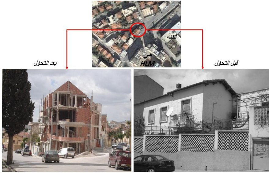
صورة (38): هدم وإعادة بناء دون تغيير في الوظيفة.
