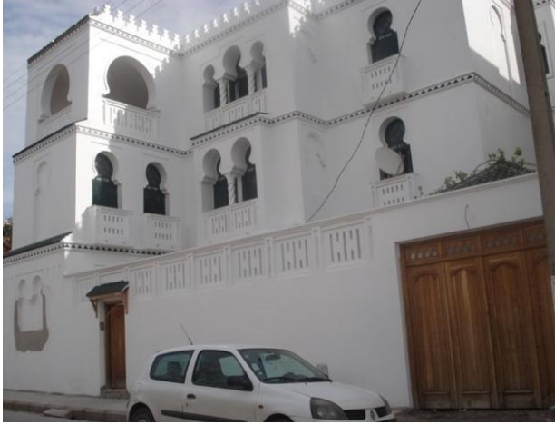
إعادة بناء بعد الهدم دون تخصيص الطابق الأرضي للنشاط التجاري
