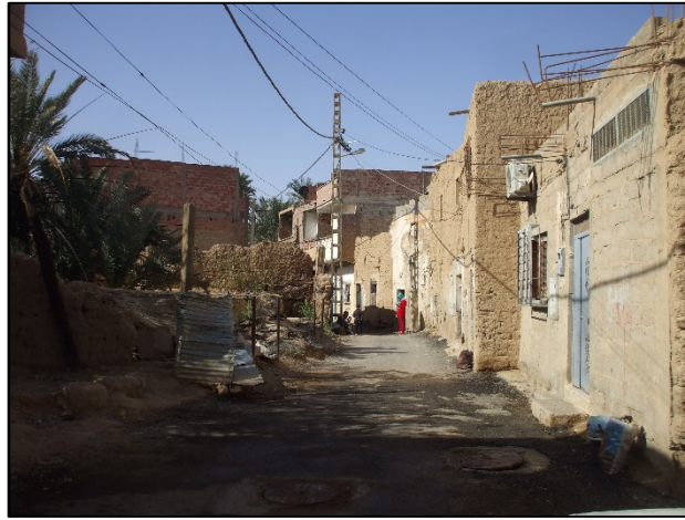
الصورة 51: تدهور واجهات بعض السكنات في حي لمسيد بسكرة القديمة المصدر: تحقيق ميداني 2015
