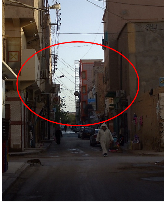
الصورة 58: فوضى في التزود بشبكة الكهرباء والهاتف بوسط مدينة بسكرة- التلوث البصري- المصدر: تحقيق ميداني مارس 2015
