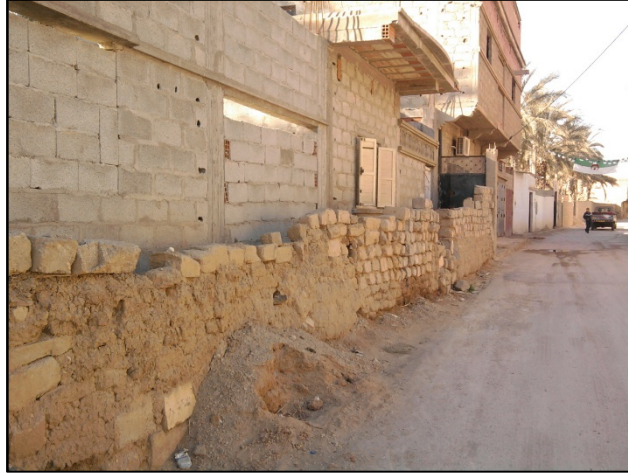
الصورة 53: استخدام مواد البناء الحديثة في عملية تجديد المساكن بجانب مواد البناء القديمة-حي مسيد بسكرة القديمة- المصدر: تحقيق ميداني 2015
