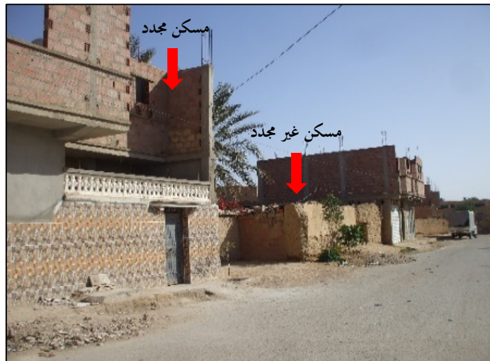
الصورة 47: مسكن تقليدي جدد بمواد البناء الحديثة وبجواره مسكن تقليدي لم يجدد (بسكرة القديمة)
