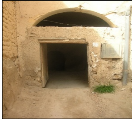
الصورة 27: شكل الحارة في مدينة طولقة القديمة المصدر: تحقيق ميداني 2015
