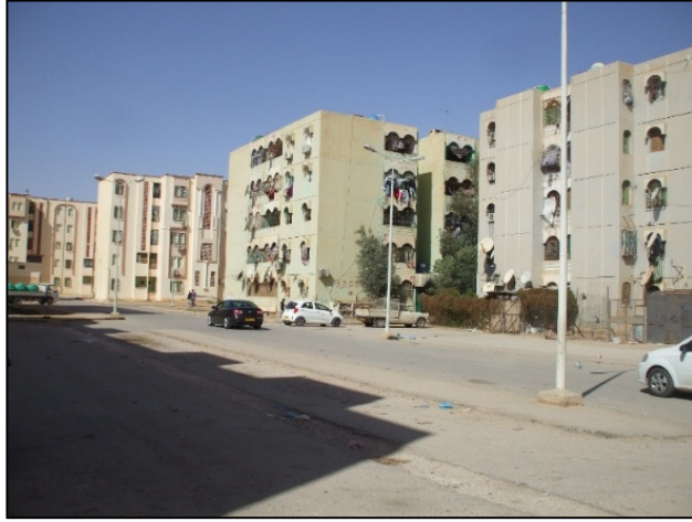
الصورة 50: المنطقة السكنية الحضرية الشرقية بمدينة بسكرة: تلوث بصري بسبب التدخل على الواجهات المصدر: تحقيق ميداني أبريل 2015
