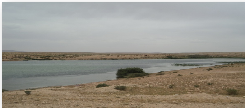
Figure: Barrage de Bougezoul
