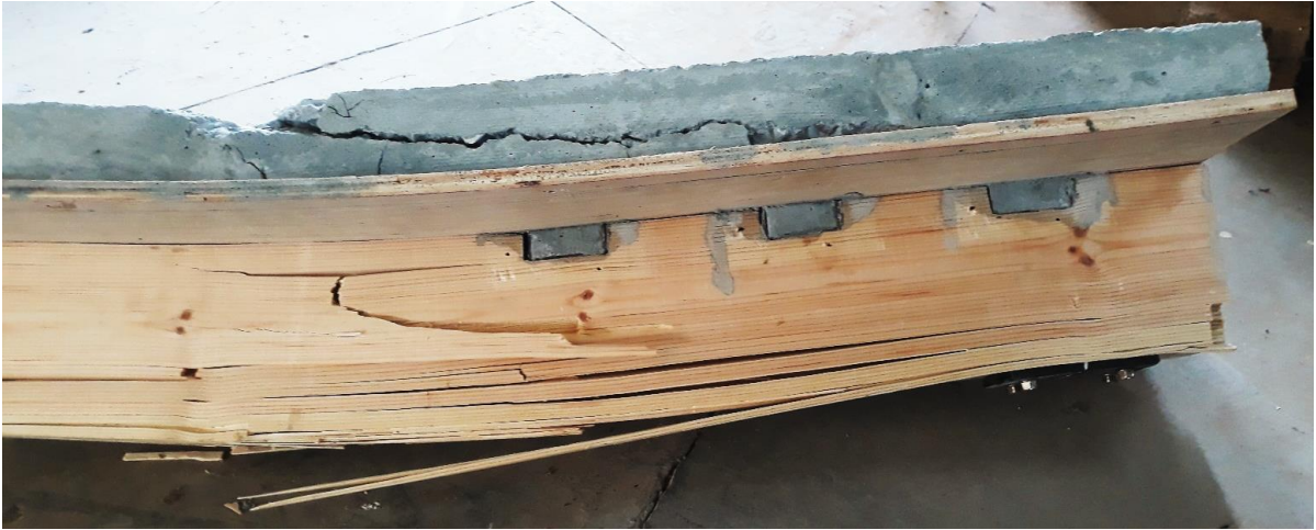
Figure 5.17: Propagation des fractures le long de la poutre de bois après l'effondrement de la poutre mixte B+INC .
