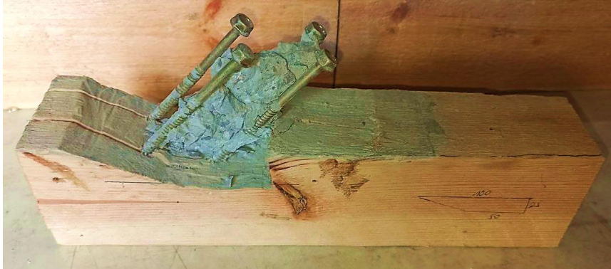
Figure 4.29: béton coincé entre les vis de renforcement de la connexion (TRZ).
