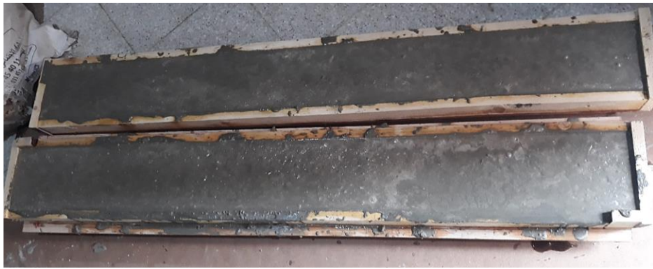
Figure A.19: Coulage de béton pour les poutres mixtes
