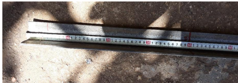
Figure A.2: mesure des cornières en acier avant découpage – début de fabrication
