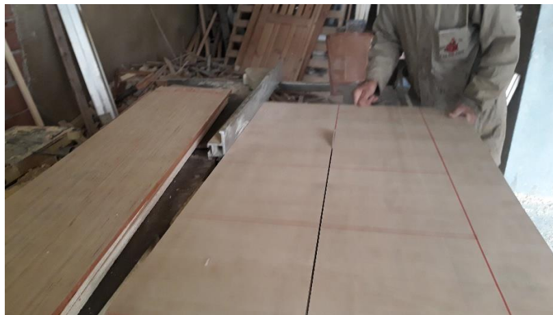
Figure A.14: contreplaqué pour le coffrage des poutres mixtes
