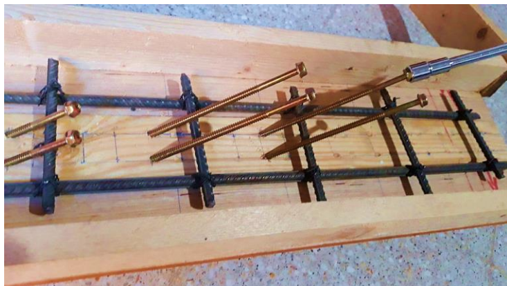
Figure A.18: Insertion des vis connecteurs dans la poutre mixte.
