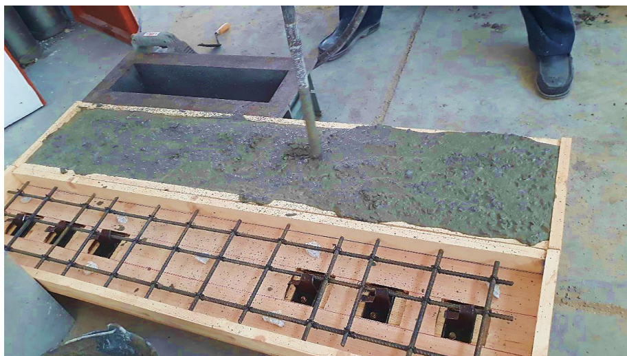
Figure 5.7: Coulage des poutres mixtes B+s et B+INC et vibration de béton.
