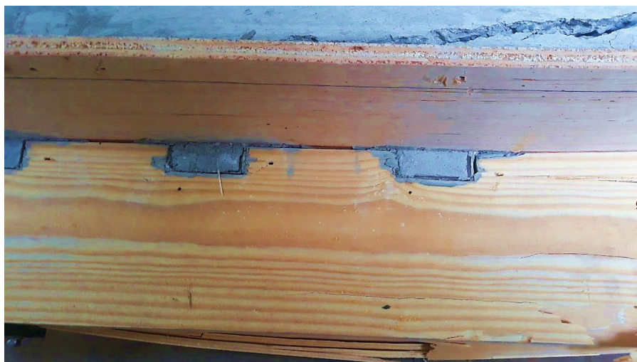
Figure 5.19: Les connexions de la poutre B+ INC après l'essai.
