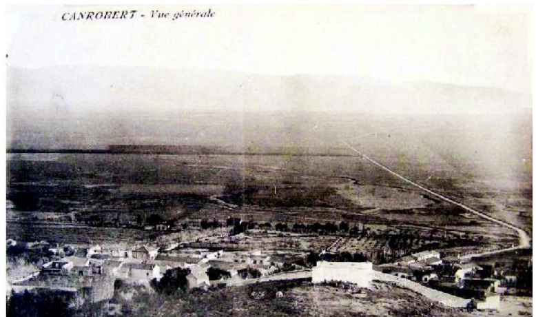
Photo n°17: Vue générale à partir du Fort Source : www.alger-roi.fr
