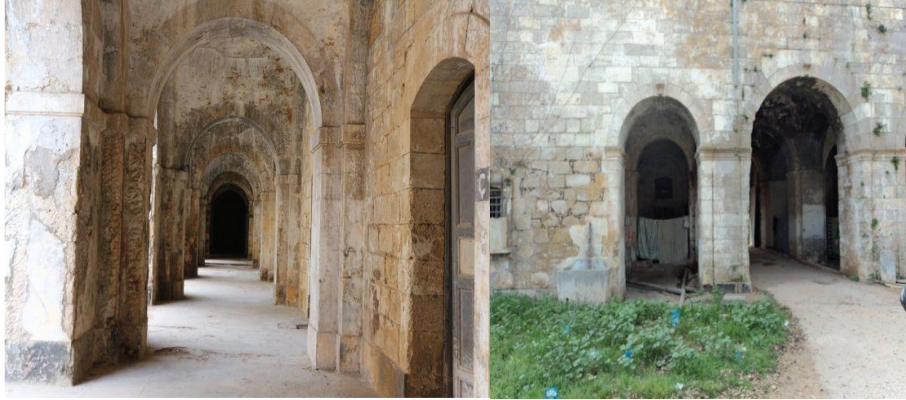
صورة (05): مدخل القلعة من الجهة الداخلية.
