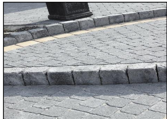
Photo n°129 : Type de pavage choisi pour le revêtement des escaliers
