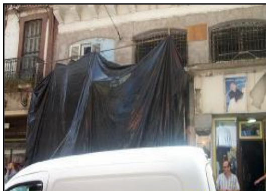
Photo n°49 : Ravalement des façades de la rue Larbi Ben M'hidi, vieille ville de Constantine
