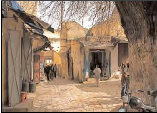
Photo n°12 : Dégradation des murs et des façades de la médina de Meknès
