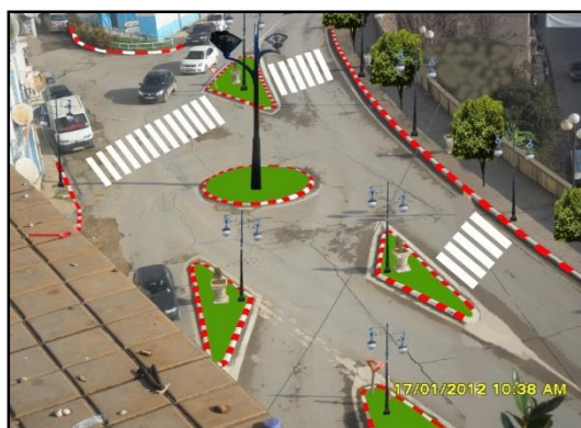
Photo n°132 : Carrefour de la rue BOUCHEBAH Youcef après le traitement
