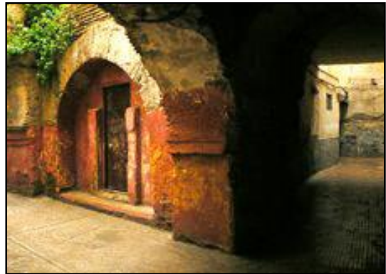
Photo n°07 : Dégradation des ruelles de Meknès
