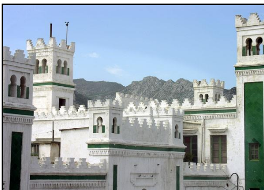
Photo n°28 : Une mosquée restaurée de la vieille ville de Tétouan
