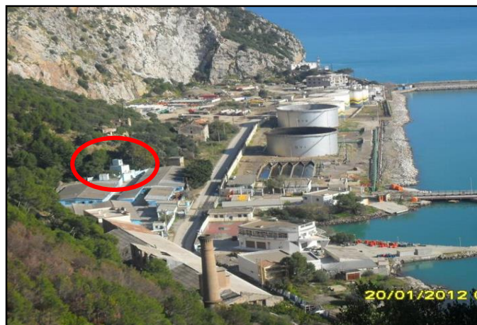
Photo n°55 : Habitation construite dans le couloir de servitude du port pétrolier
