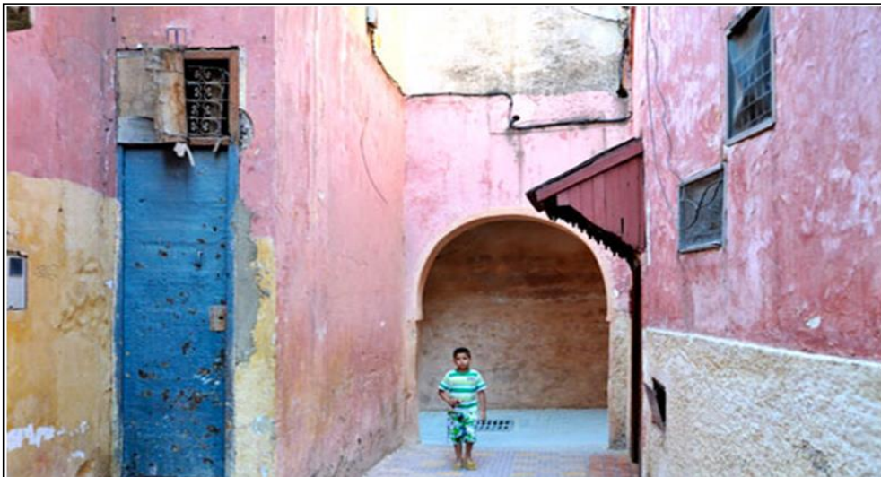
Photo n°14 : Dégradation des murs de la médina de Meknès
