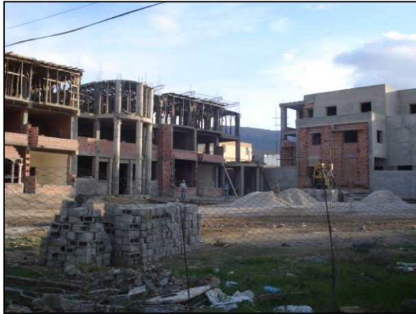
Vue sur une nouvelle Cité administrative
