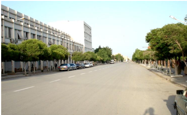
Figure n°36 : Vue sur le boulevard de la wilaya coté Est
