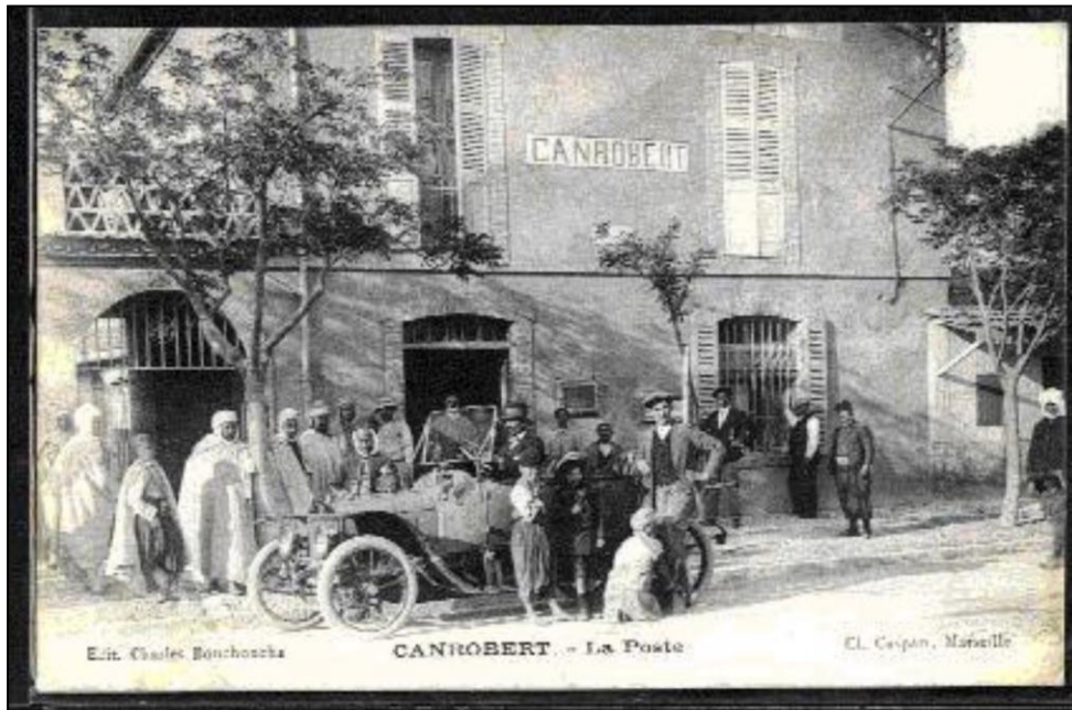
Figure n° 37 : la poste de Canrobert
