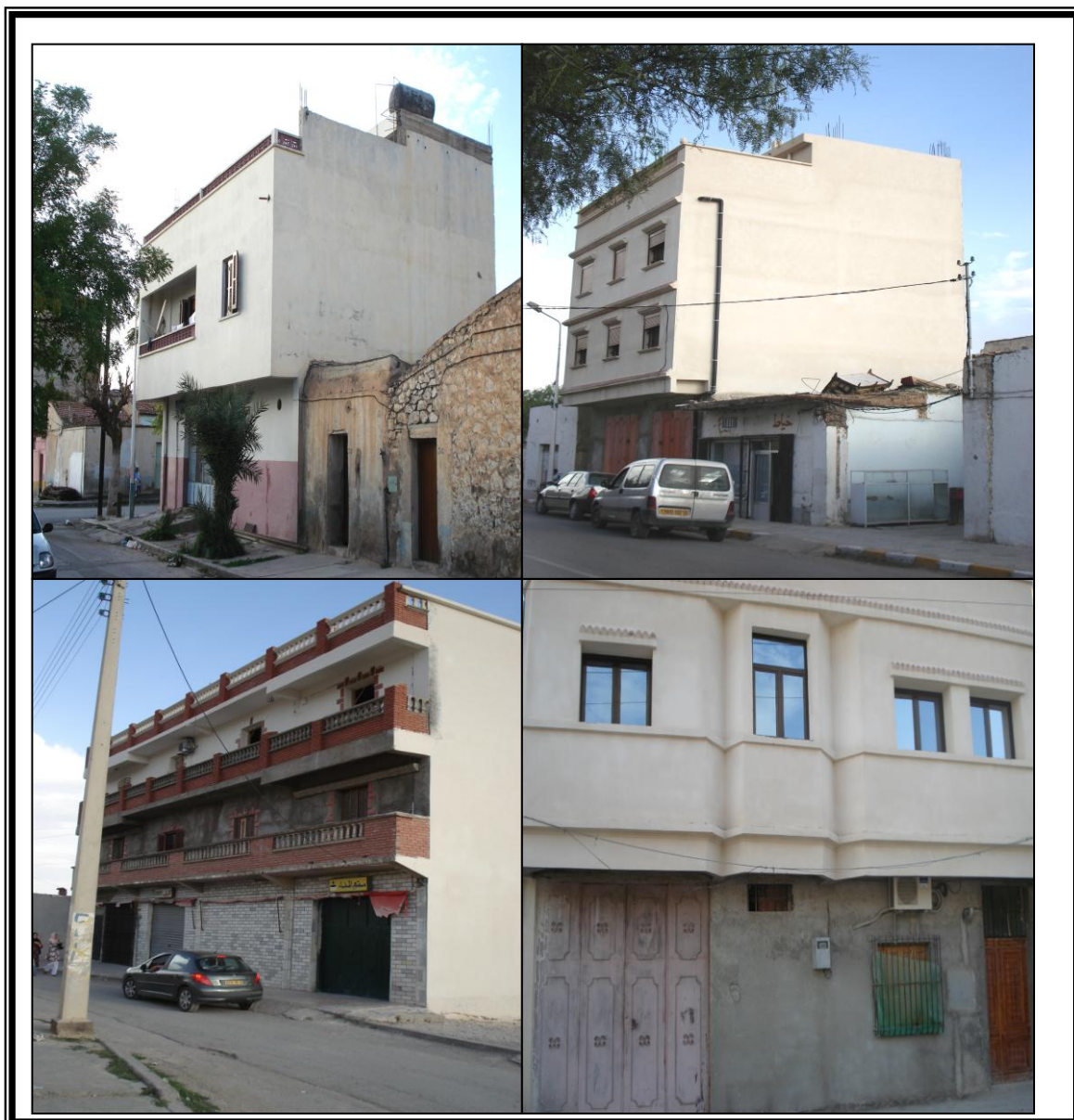
Figure n° : 60 : Exemples de surélévation au centre ville ancien
