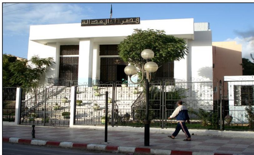
Figure n° 62 : le palais de justice : Première construction étatique au centre- ville ancien
