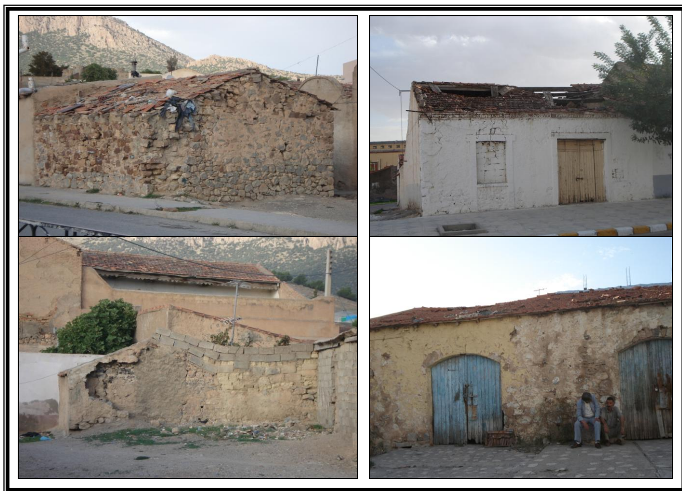
Figure n°:57 cadre bâti en mauvais état (centre ancien)
