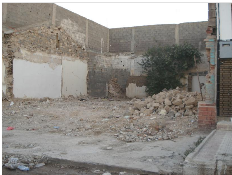
Figure n°59: Cas d'une démolition d'une habitation traditionnelle
