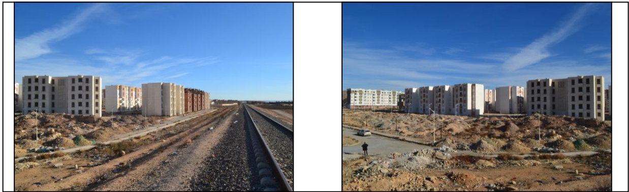
Figure n°97 : photos qui présentent la localisation de quelques programmes de logements sociaux
