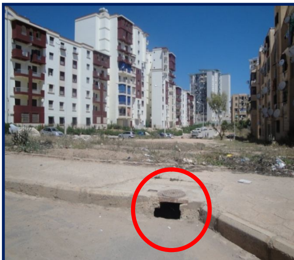
Photo n°19: état des avaloirs
