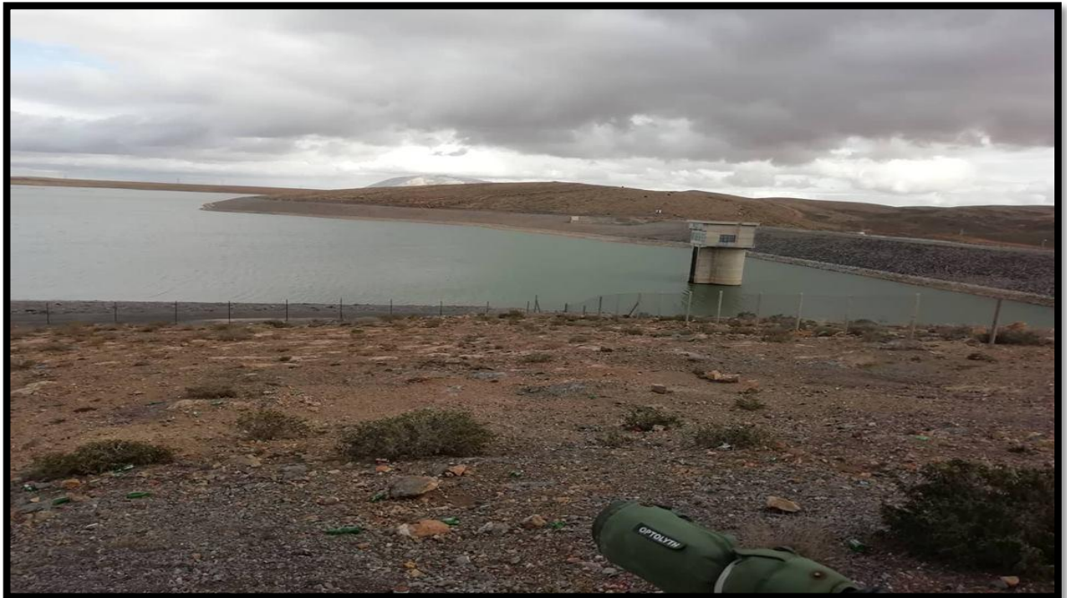
Figure.4 - vue général du barrage d'Ourkis durant l'année 2017-2018 (Photographie originale)
