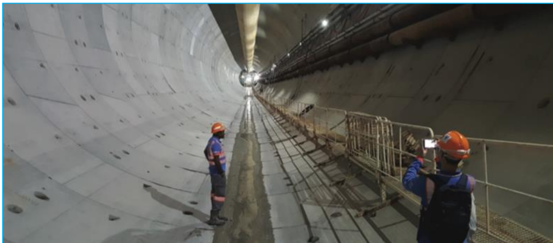
Figure 4.1 Le projet après la réalisation [57].
