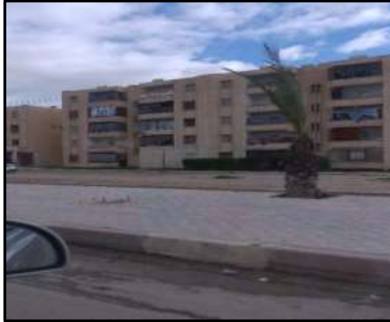
Photo N°23 : habitat collectif moderne
